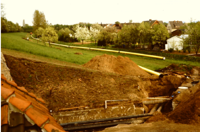
Bauarbeiten an der umstrittenen Gasleitung
